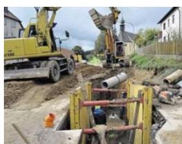
Seit Ende August graben sich die Baumaschinen der Firma Baumer aus Oberviechtach durch den Asphalt der Kreisstraße SAD 38 im Ortsbereich von Pischdorf. Auf einer Länge von 500 Meter wird die Straße erneuert. Derzeit verlegen die Bauarbeiter den Regenwasserkanal im Straßenbereich. Die endgültige Fertigstellung ist bis Juli 2022 geplant.
